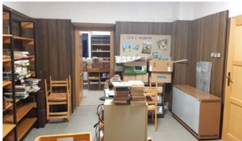
Místní knihovna v průběhu modernizace
