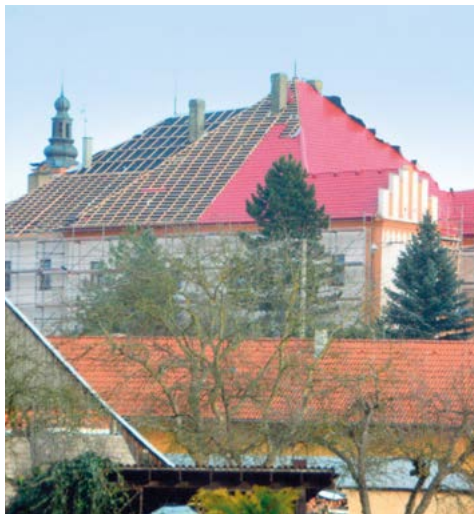
Oprava zámecké střechy v roce 2016
