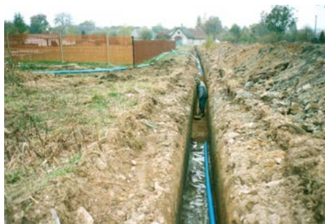
Stavba obecního vodovodu v letech 2003 a 2004
