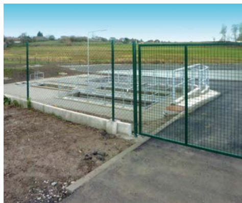
Pohled na dokončenou obecní čističku odpadních vod. Stavba byla dokončena v létě 2013.
